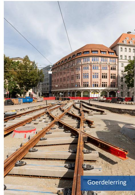
In dieser Phase wurden durch die LVB einige Bauartänderungen eingeführt, die durch Konstruktion und Fertigung umzusetzen waren. Das waren u.a. die Einführung der Betonunterschwellung sowie in Einzelprojekten auch die Einführung von Kunststoffunterschwellungen.
